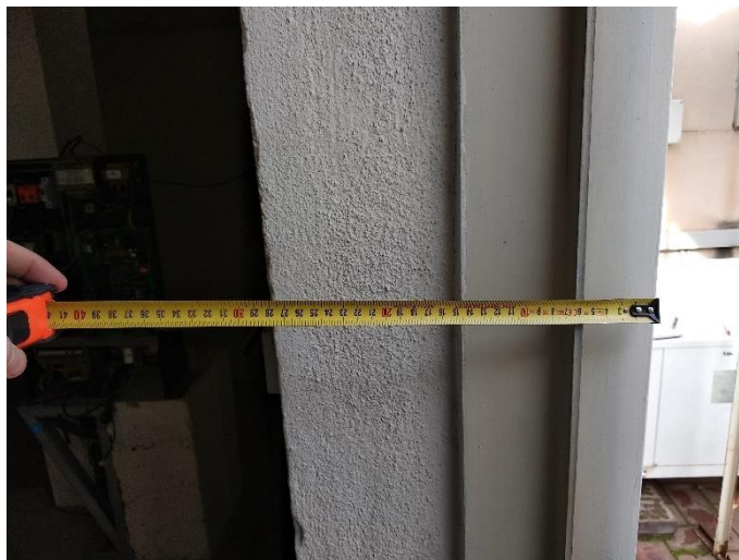
Imatge1-59. Mur de façana d'accés a Sala Màquines Ascensor - Zona de demolició.
