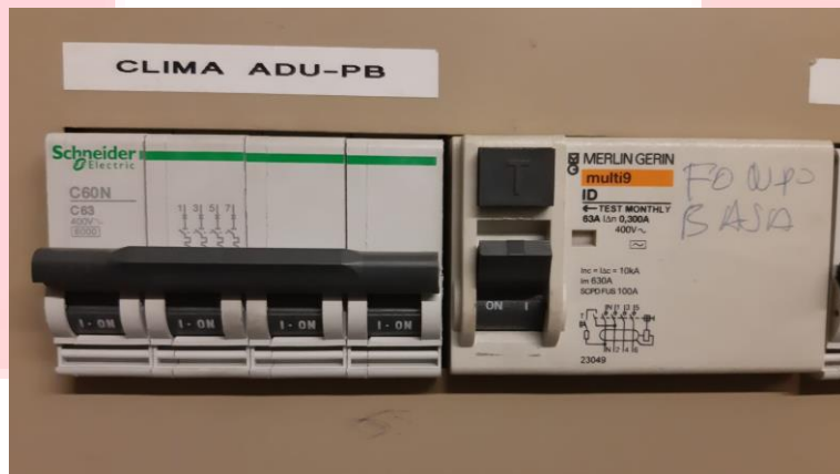
Imatge1-14. Proteccions tèrmica i diferencial equip climatització Sala Adults Planta Baixa.
