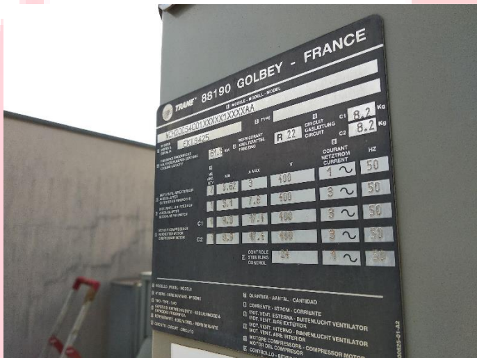
Imatge1-28. Equip RoofTop Zona F - Sala Adults triple altura – Placa de característiques TRANE WCH 200
