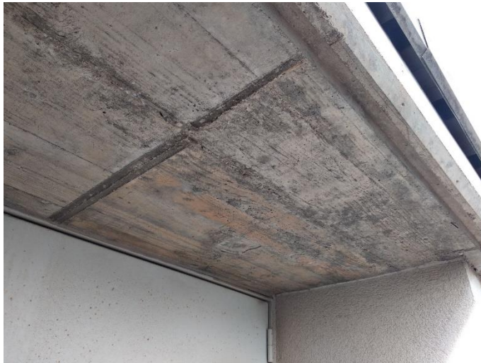
Imatge1-56. Zona de forjat volat - Zona de demolició - Sobre la porta.
