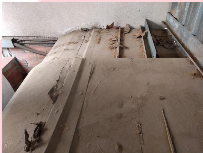
Imatge1-42. Equip RoofTop Zona B Sala Infantil – Conductes d'impulsió i retorn continuació per "Patinillo".
