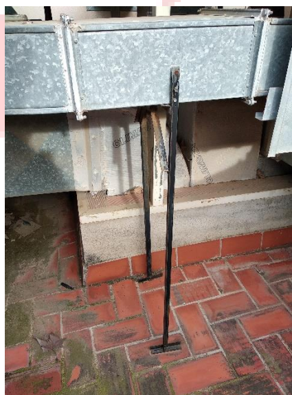
Imatge1-49. Vista general de bancades de suport conductes.
