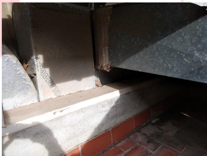
Imatge1-52. Muret perimetral "Patinillo " de conduccions Sala Infantil, Oficines, Hall i Sala Adults Triple Altura.
