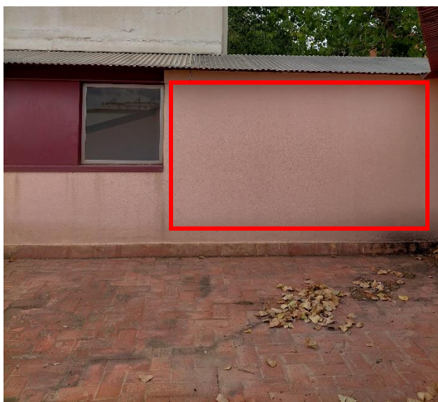
Figura 5. Localització de l'inversor i de la caixa de proteccions de CC i CA del camp fotovoltaic.
