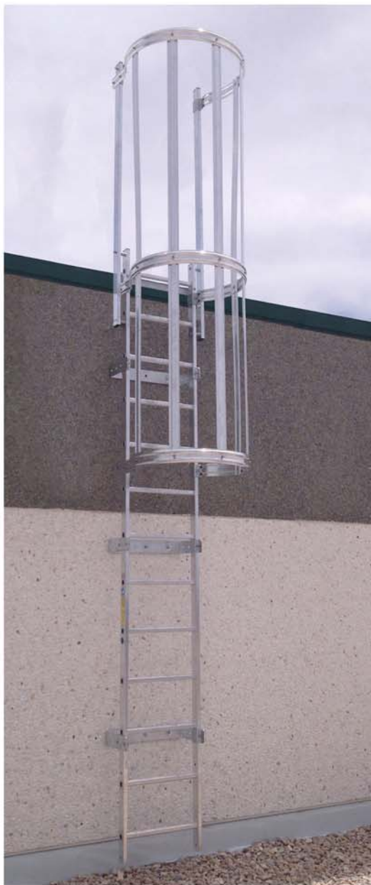
Instalación para acceso a tejado
