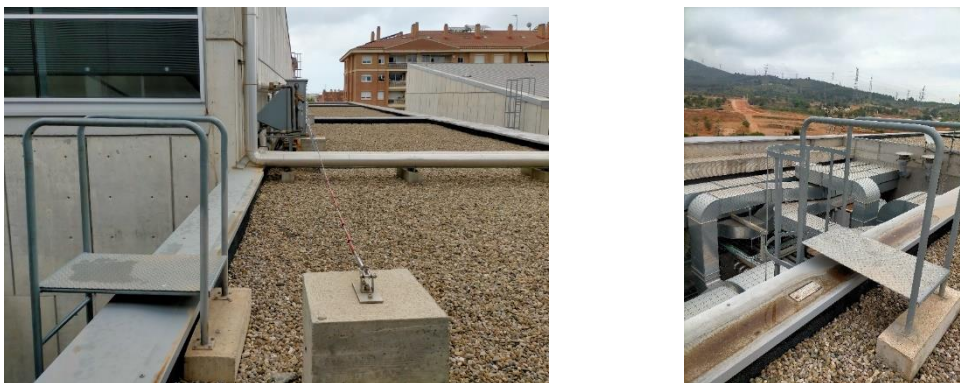
Figura 5. Escala d'accés al passadís central per accedir a la coberta de zona 1 (esquerra) i zona 3 (dreta).
