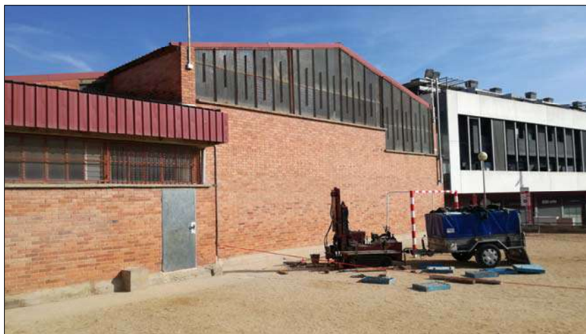
Sondeig S-5 Emplaçament
