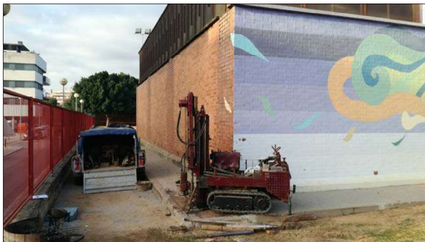
Sondeig S-1. Emplaçament
