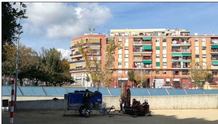
Sondeig S-4. Emplaçament
