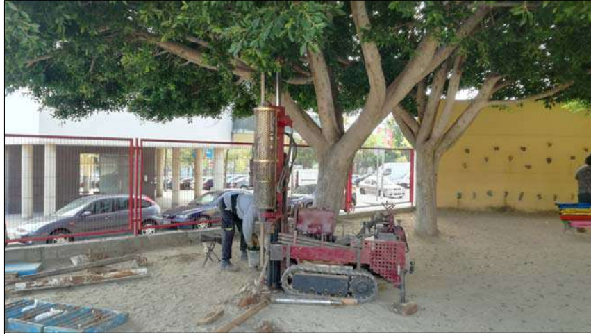
Sondeig S-2. Emplaçament
