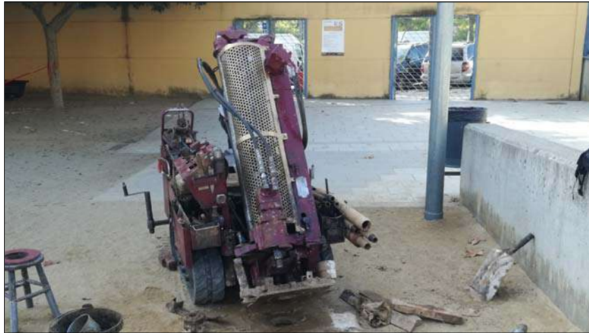
Sondeig S-3. Emplaçament
