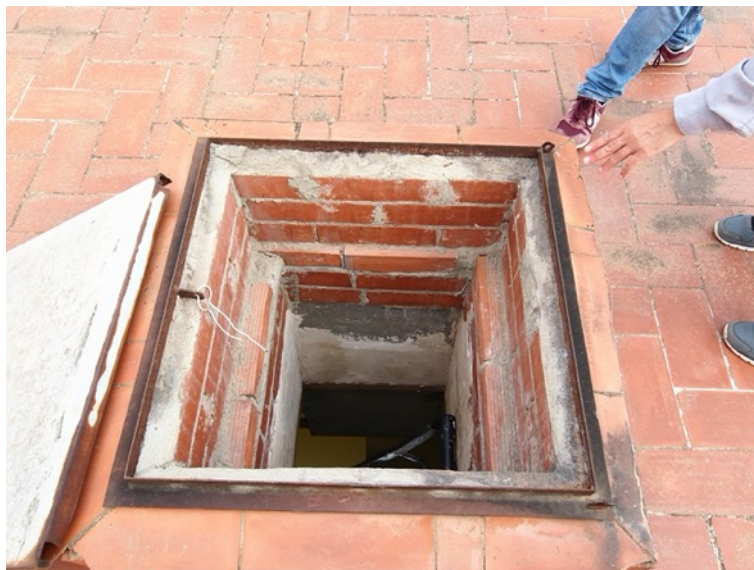
Imatge 2.2. Fotografia de l'accés a la coberta de l'escola Pau Casals.
