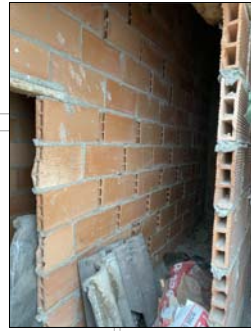
Espai sota coberta per a instal·lació d'inversors i proteccions
