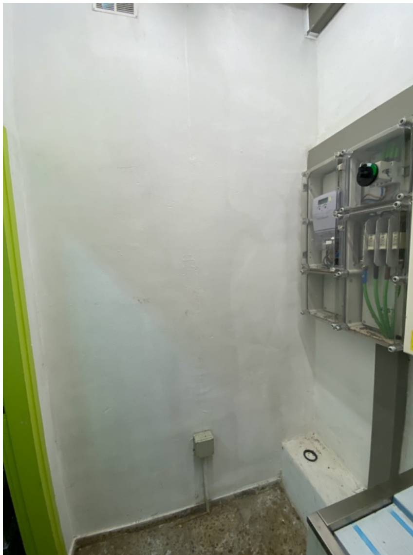
Fig. 2.3. comptador de companya del centre i espai disponible per la TMF1 de generació
