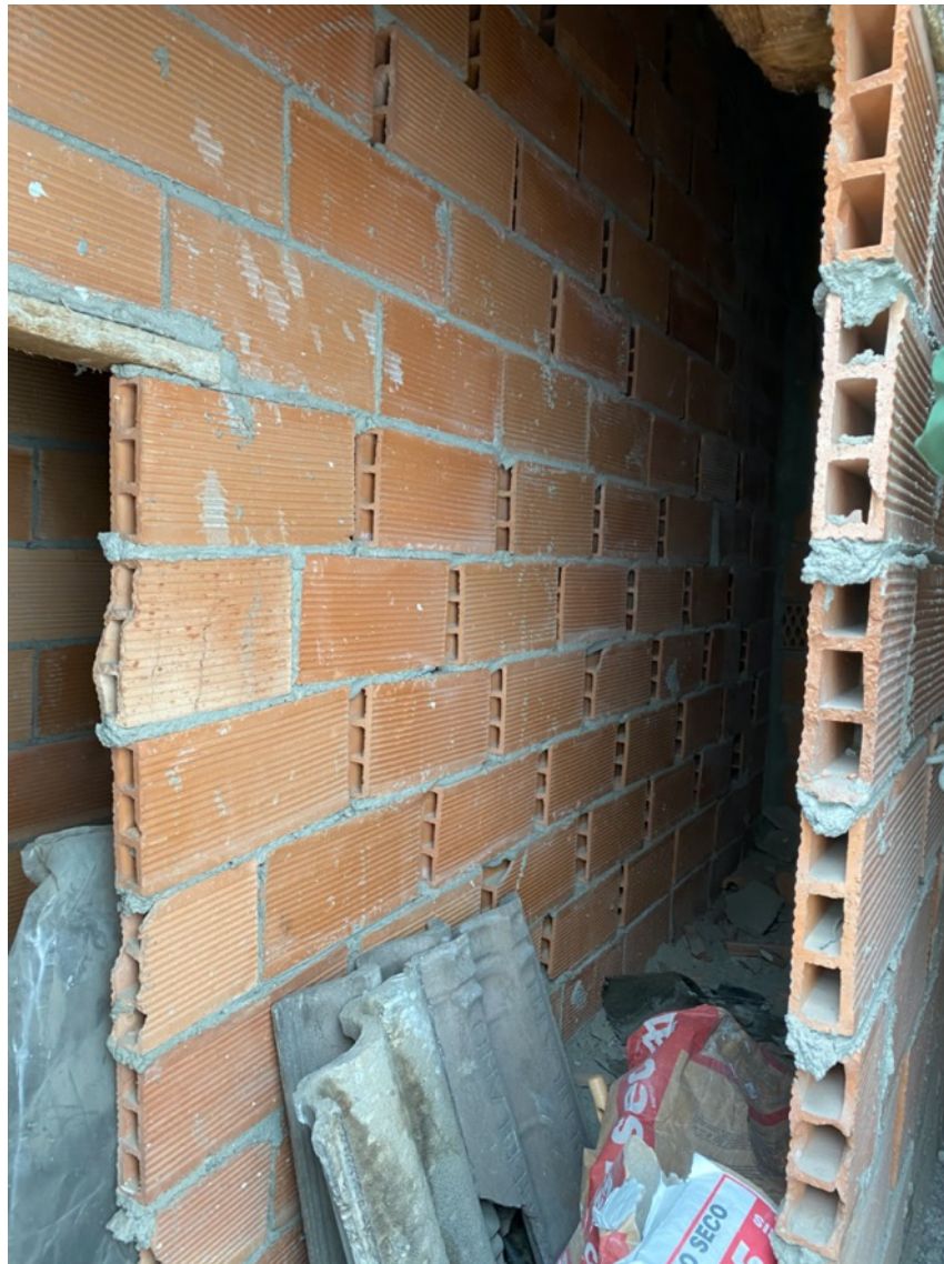
Fig. 2.2. Envàs de sostre mort on s'instal·laran els inversors i els quadres de proteccions AC/DC
