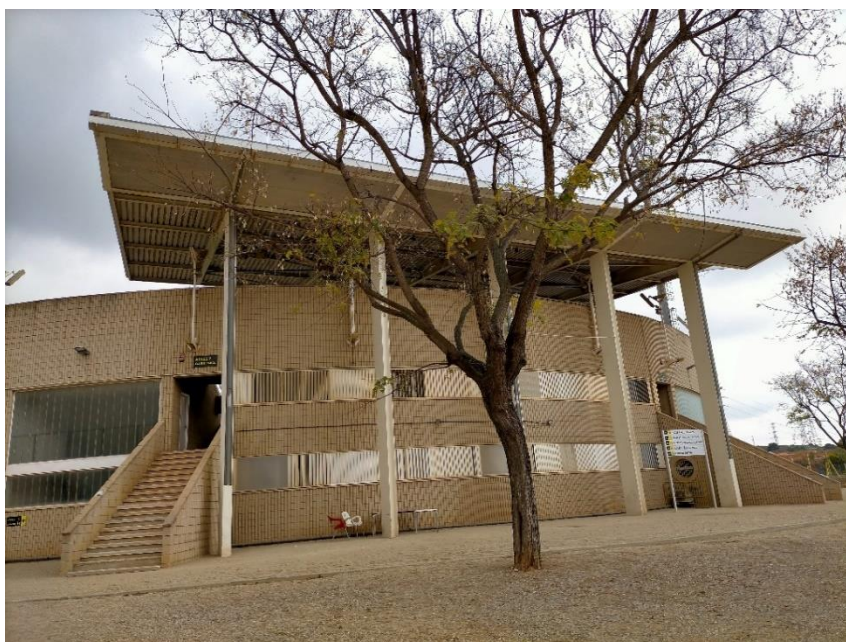
Figura 4. Vista general de la coberta de l'edifici.
