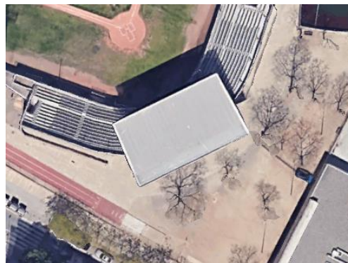
Figura 2. Coberta camp de beisbol.
