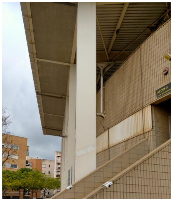
Pilars estructura coberta
