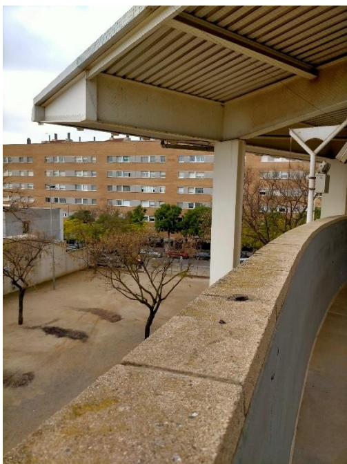
Pilars estructura coberta
