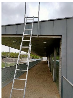
Figura 5. Accés a la coberta del camp de futbol municipal Torre Roja.
