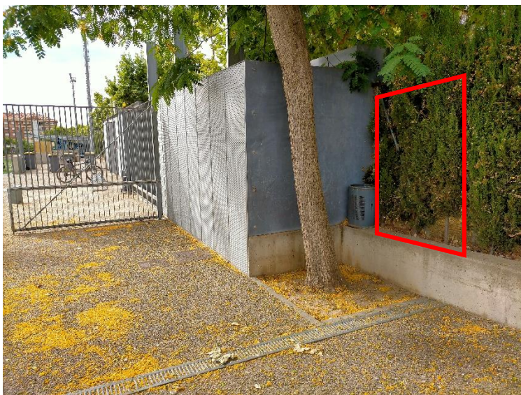
Figura 7. Localització de la nova TMF fotovoltaica amb nínxol addicional.
