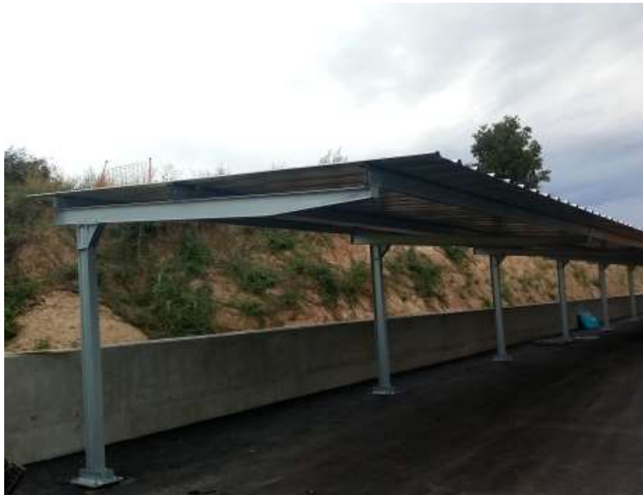
Exemple de mènsula simple amb xapa instal·lada
