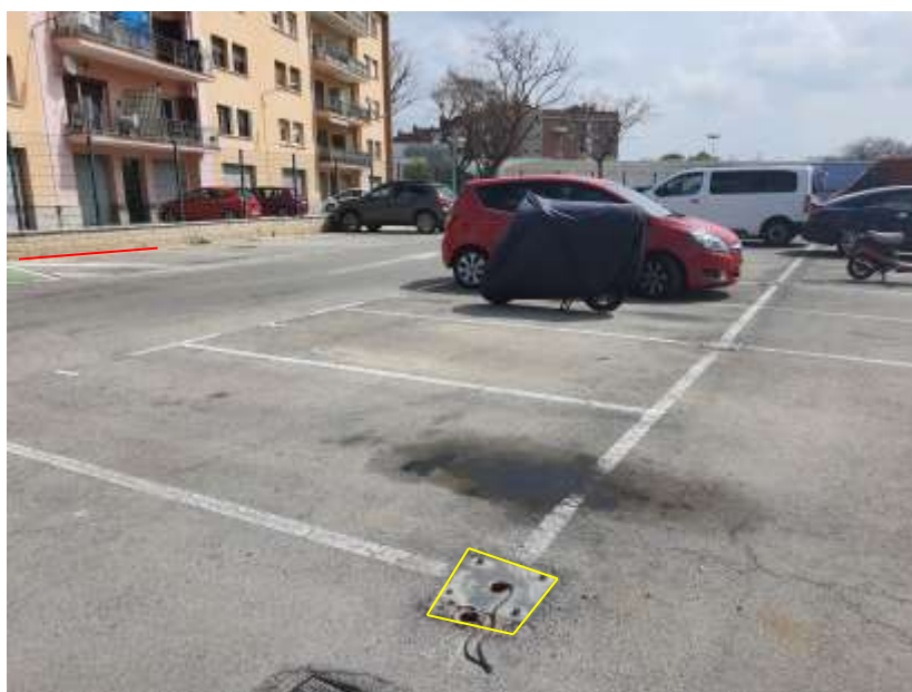
Imatge de la platina i els dos tubs corrugats
