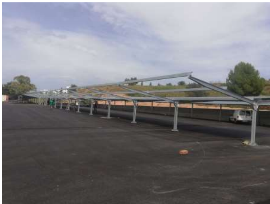
Exemple estructura mènsula doble
