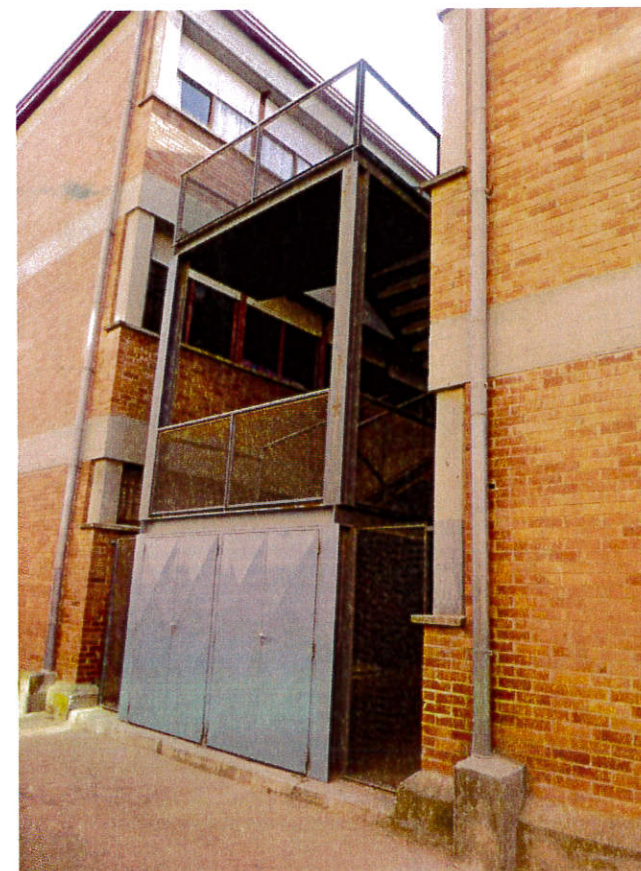
Imagen del estado actual del testero norte
