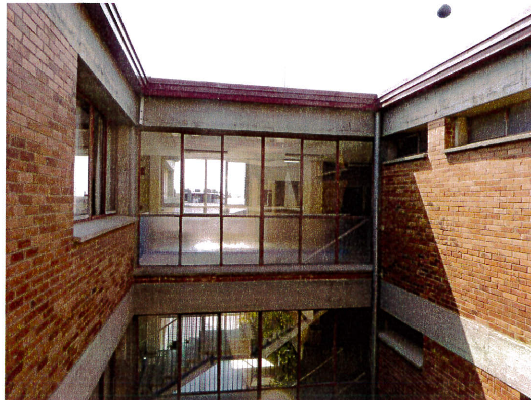
Imagen del estado actual del patio interior
