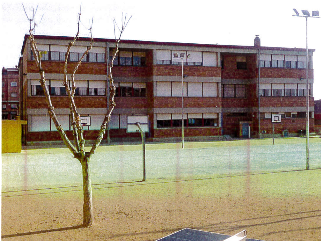
Imagen del estado actual la fachada suroeste del edificio de educación primaria
