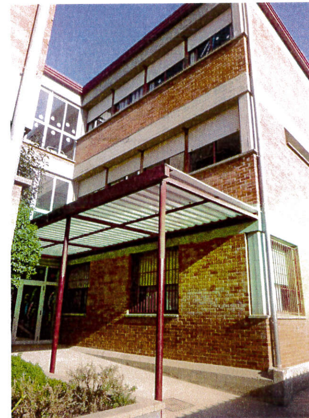
Imagen del estado actual del acceso al edificio por la fachada sur
